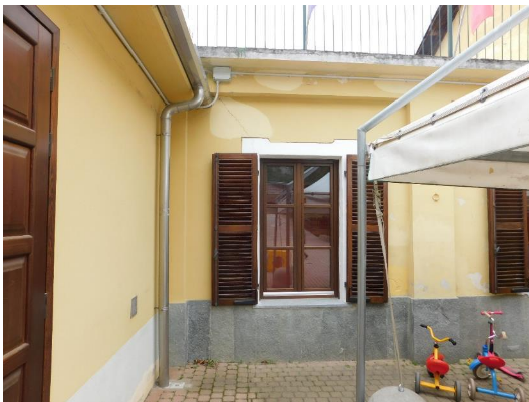
Foto 4 – Vista lato cortile, prospetto Nord
