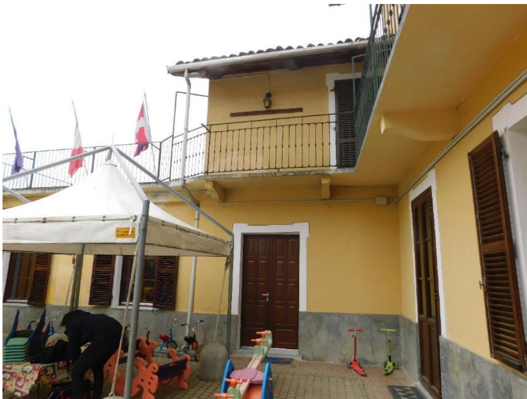
Foto 3 – Vista lato cortile, prospetto Nord
