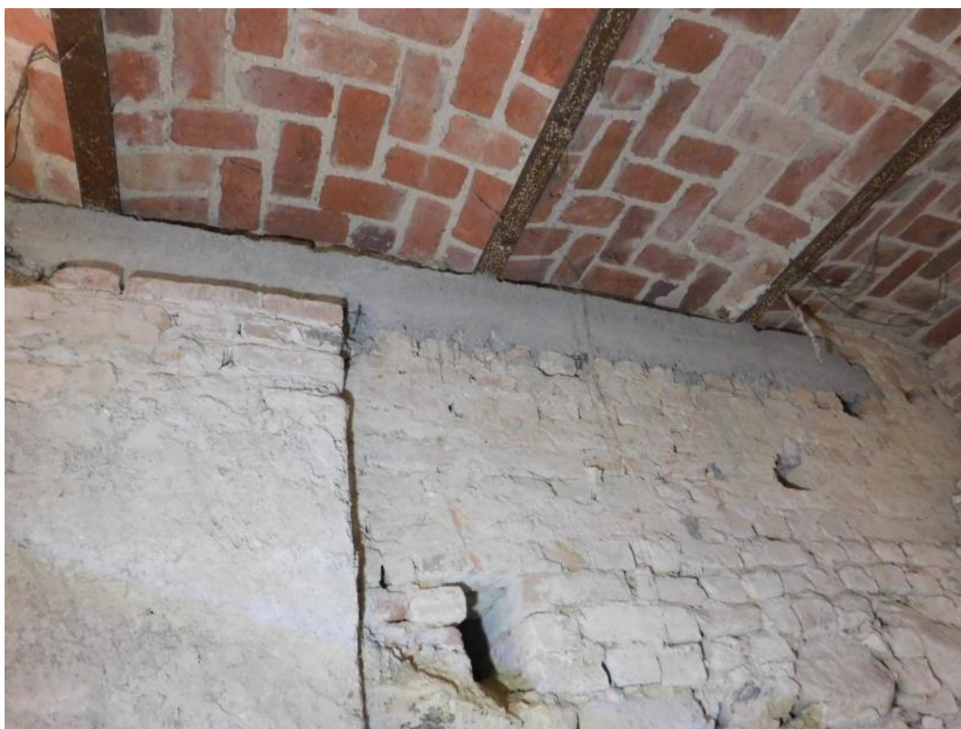
Foto 26 – Vista voltine e cordolo locale seminterrato
