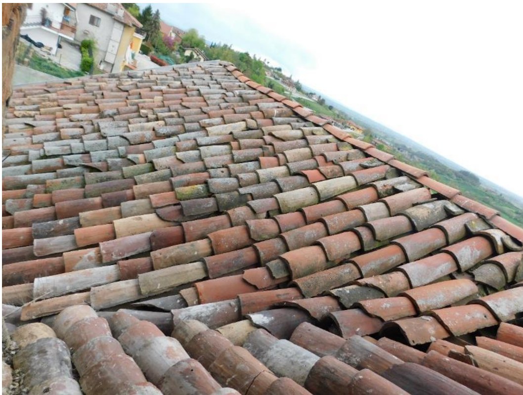
Foto 43 – Vista copertura fabbricato B
