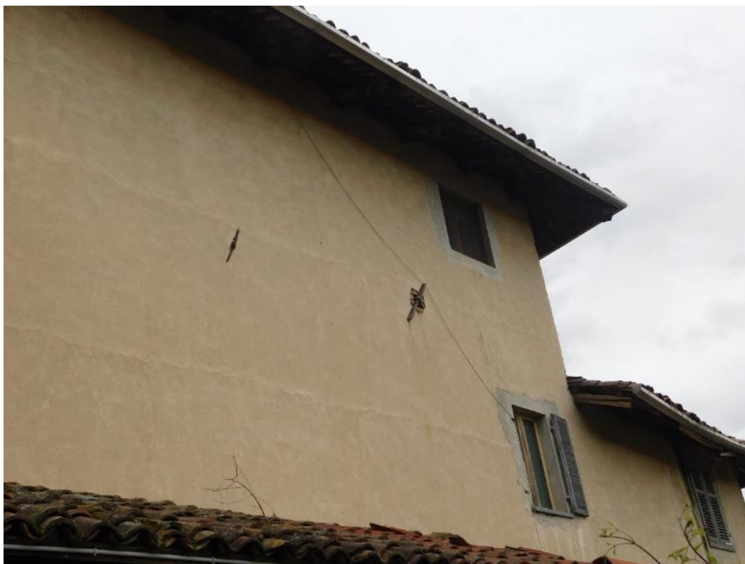
Foto 47 – Vista prospetto Ovest
