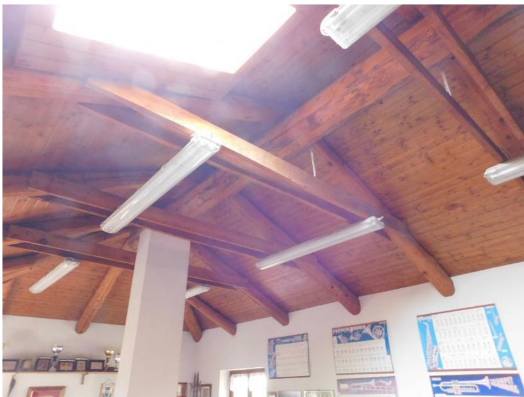
Foto 40 – Vista sala prove, copertura fabbricato A
