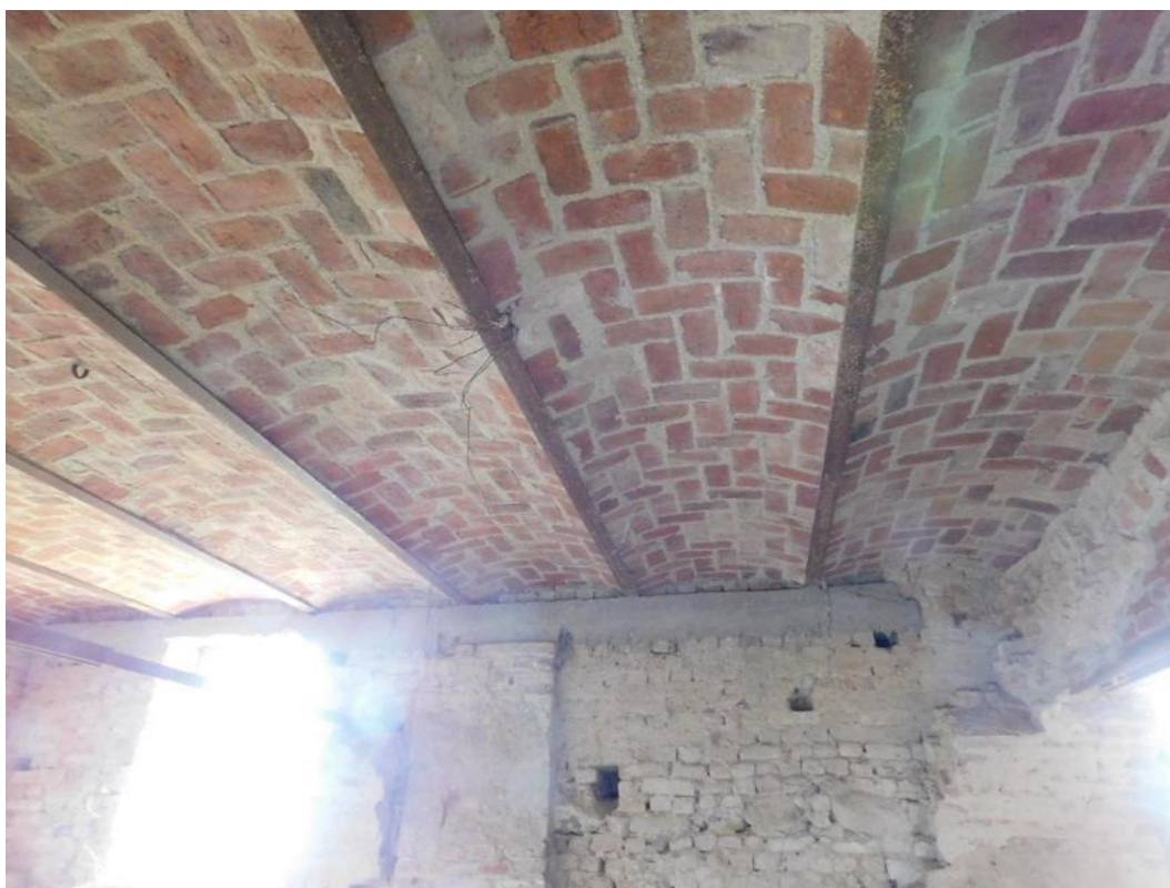
Foto 24 – Vista voltine locale seminterrato
