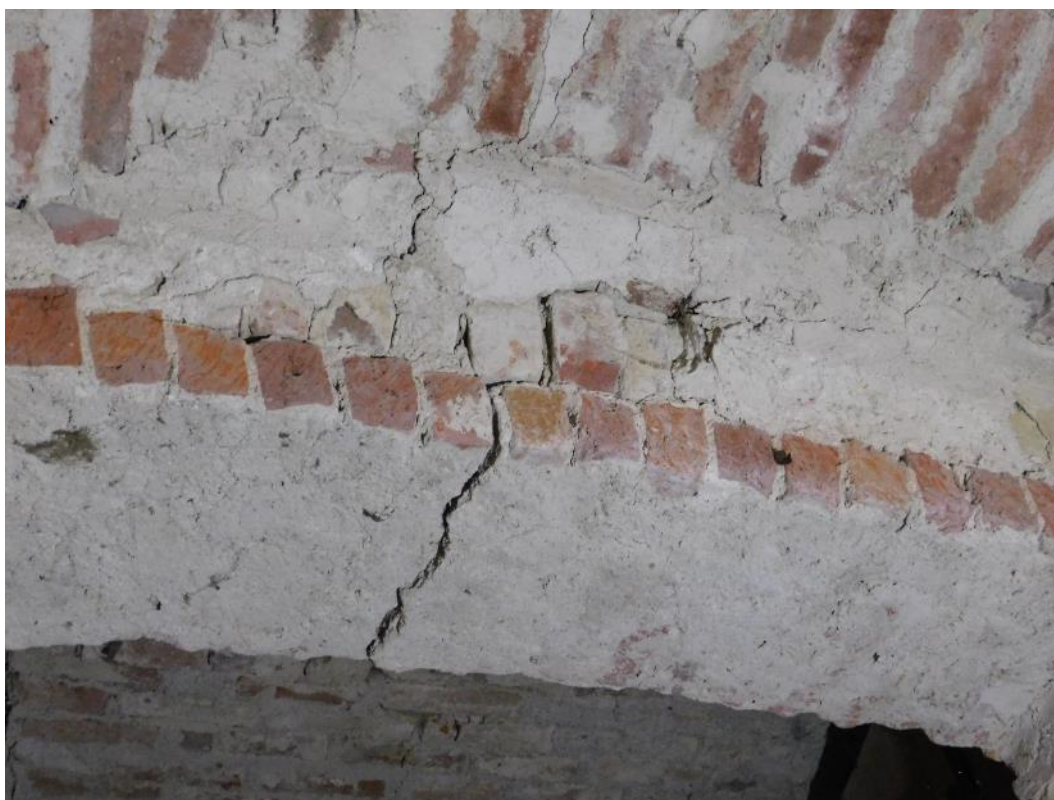
Foto 28 – Vista lesione architrave in muratura
