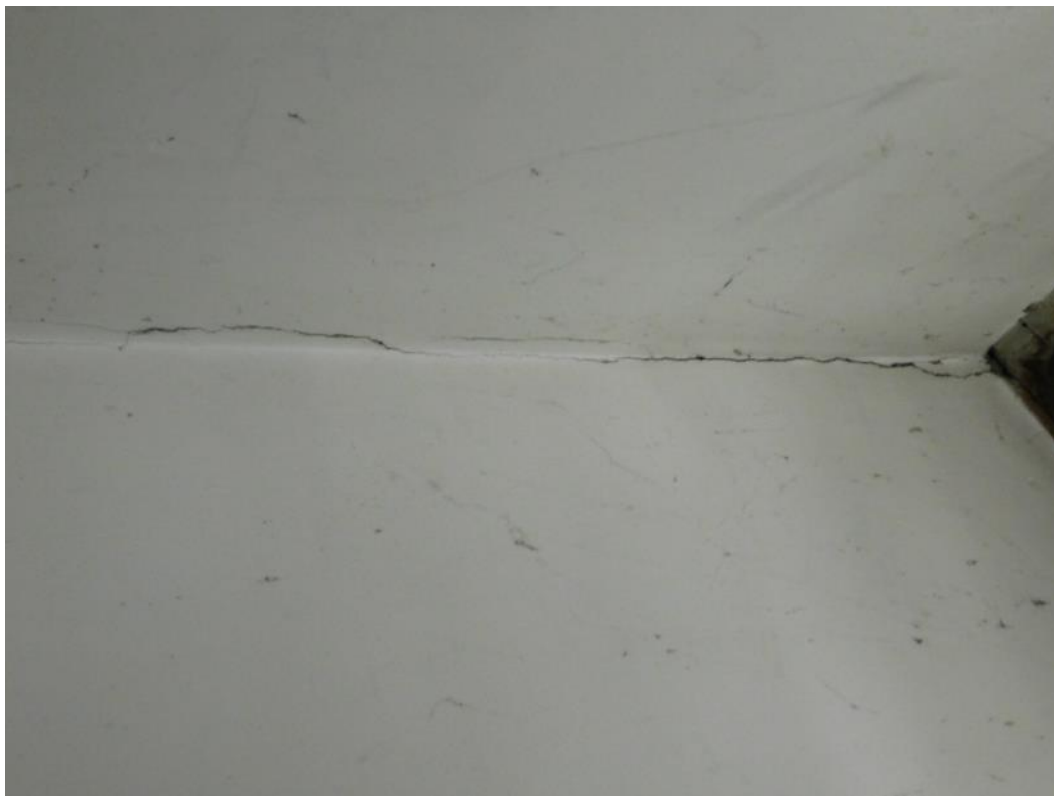
Foto 39 – Vista ravvicinata lesione ad angolo sub-verticale, archivio storico
