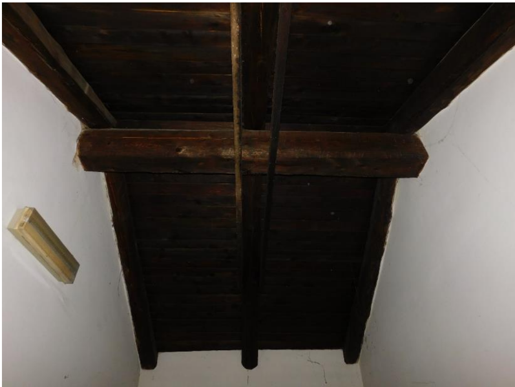
Foto 36 – Vista disimpegno, copertura fabbricato A
