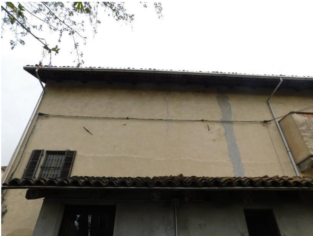
Foto 45 – Vista Prospetto Ovest
