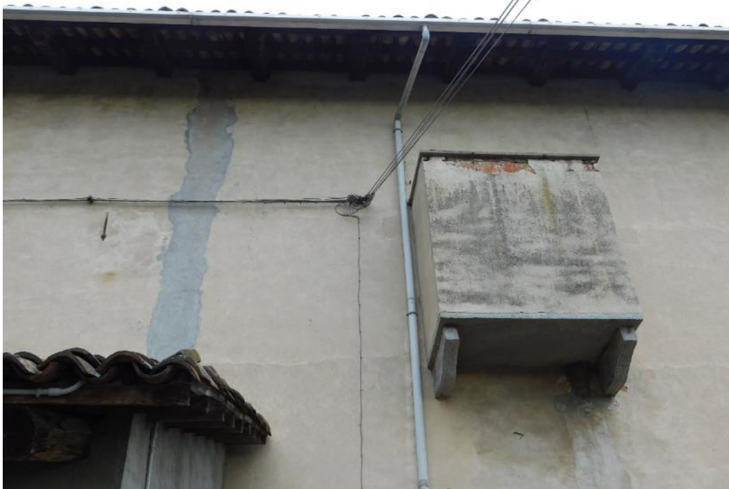
Foto 46 – Vista prospetto Ovest
