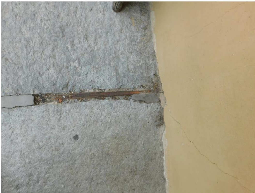
Foto 31 – Vista ravvicinata ballatoio
