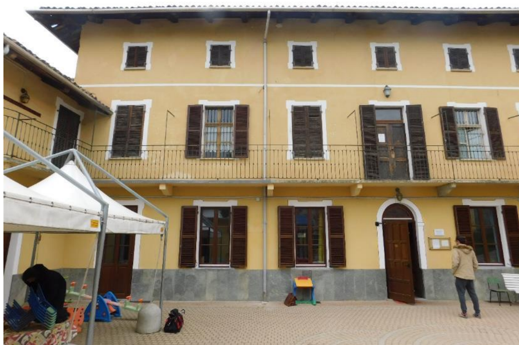
Foto 1 – Vista lato cortile, prospetto Est
