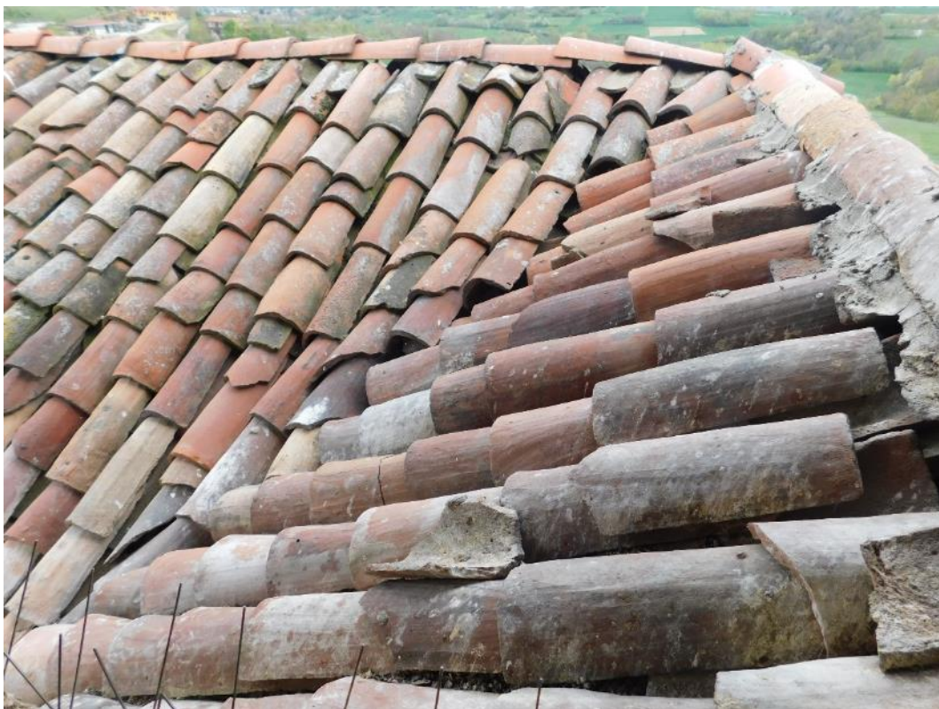
Foto 44 – Vista copertura fabbricato B
