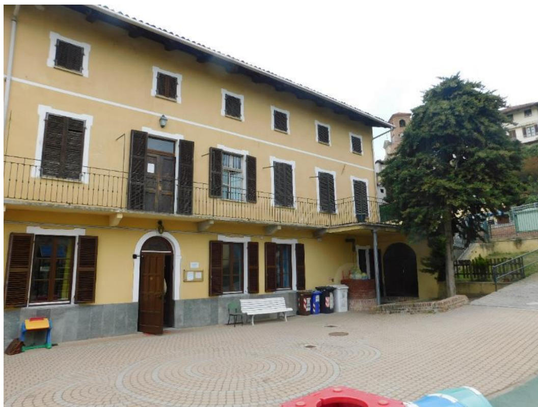
Foto 2 – Vista lato cortile, prospetto Est
