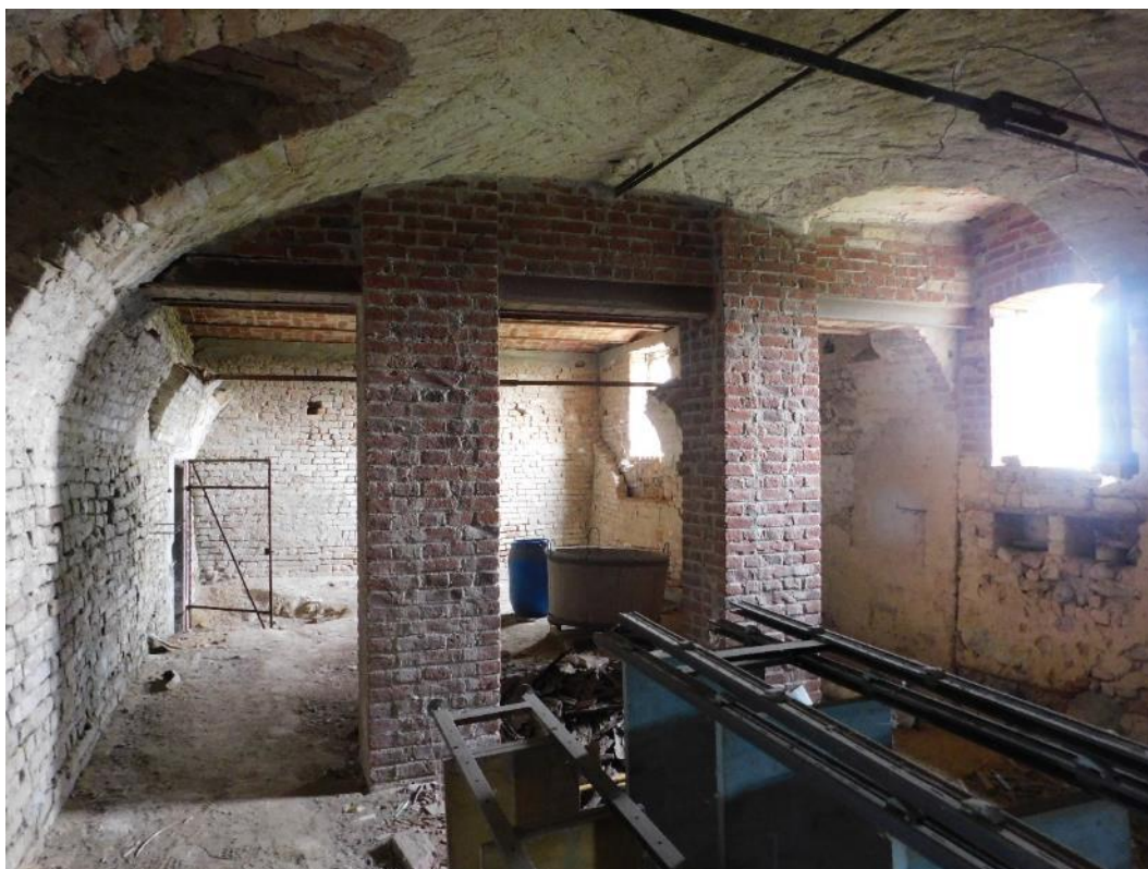
Foto 23 – Vista locale seminterrato
